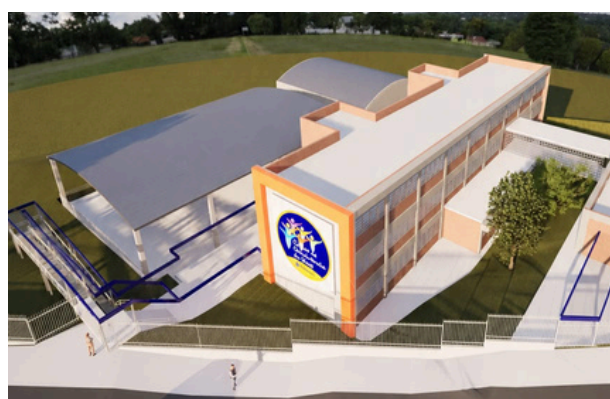
O espaço está sendo construído na Rua Alagoas e está prevista para 2027
