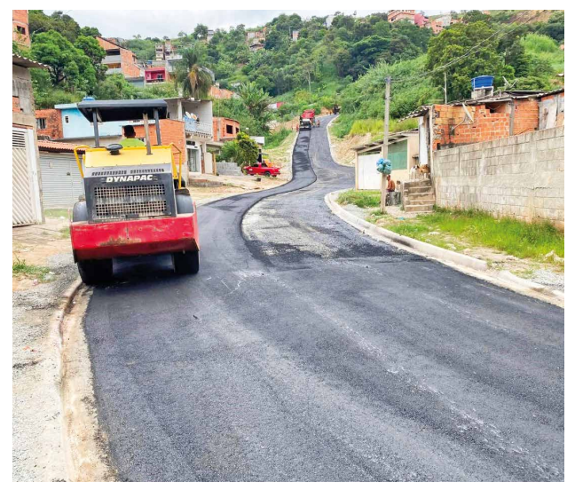
Nova via de acesso foi construída no Parque Paraíso
